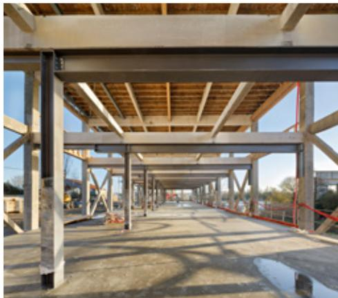
La contrainte du parasismique est résolue en deux temps. Tout d'abord, avec une extension désolidarisée de l'existant et conforme à la norme sismique et ensuite, pour le bâti existant, une vulnérabilité au séisme non aggravée puisque sa rigidité est nettement améliorée par un contreventement intégralement reconstitué.
