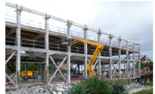
**Reconstruction.** Renfort de fondation, réalisation de micro pieux pour la nouvelle file intermédiaire, apport de la structure métallique de renfort et des croix de contreventement, repose et rehausse de la charpente métal sablée, consolidée et repeinte, pose d'une nouvelle couverture, inscription des ensembles menuisés aluminium, etc. Sans oublier, la restauration patiente et «laborieuse» des bétons.
