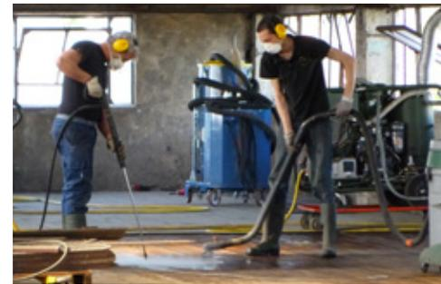
**Déconstruction.** Démolition du bâtiment annexe Est et de l'escalier Nord, sciage du plancher RDC pour implanter les réseaux et resituer un nouveau RDC au-dessus de la côte inondable, démontage du plancher N+1, frangement et rabotage des poutres béton en plancher haut du RDC, dépose des façades non
