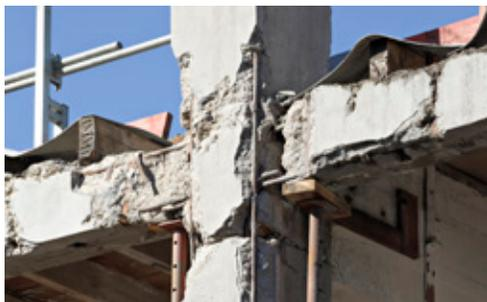
Des reprises du dispositif constructif sont donc nécessaires. Ainsi, pour supporter les « charges d'exploitation » liées à la nouvelle affectation du bâtiment, les poutres principales existantes sont « soulagées », file par file, par un poteau intermédiaire au quart de la portée rendant possible leur justification en l'état. Par souci de lisibilité patrimoniale, ces nouveaux poteaux sont réalisés en acier.
